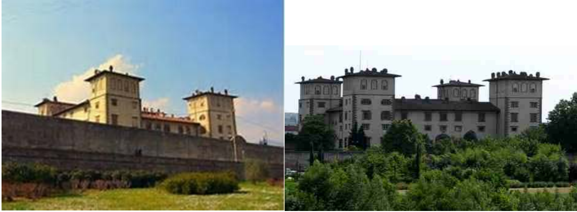
Villa Montelupo da Filicaia
